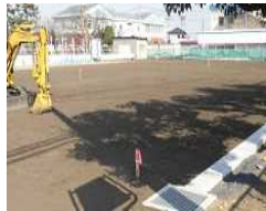
幼稚園跡地の芝生化工事
