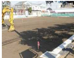
幼稚園跡地の芝生化工事
